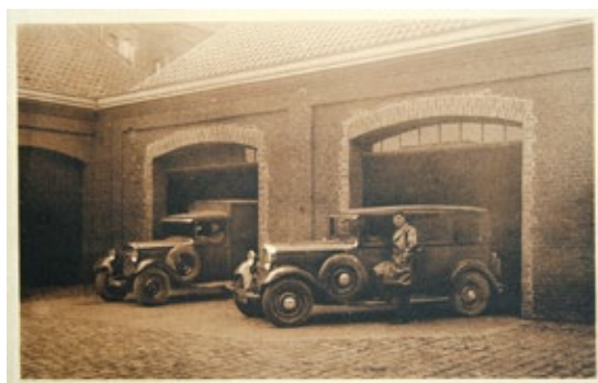
+ Vue du garage dans les années 1930.
