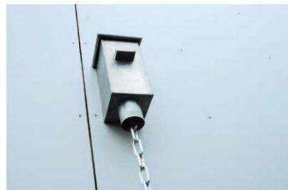
Cette photo a été prise sur le chantier du nouveau CMP à Watrelos. C'est le haut de la gouttière murale, non pas cylindrique mais composée d'une chaîne tendue jusqu'au sol. L'eau s'écoule le long des chaînons donnant à cette gouttière atypique un aspect étonnant.
